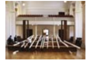
2018 baute Juri Troy eine schräge Ebene in die Barockkapelle des Konservatoriums, indem er die bestehenden Kirchenbänke als Unterkonstruktion verwendete.
